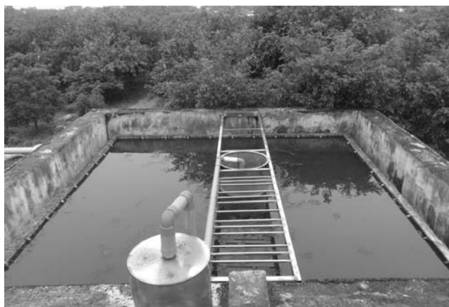
Hệ thống xử lý chất thải chăn nuôi tập trung của xã Ngọc Lũ (Hà Nam) được đầu tư 7 tỷ đồng nhưng không hoạt động do không có kinh phí vận hành
