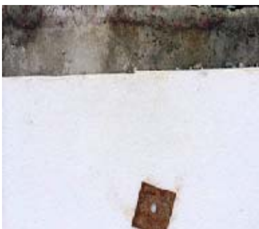
Hình 9: Ốp tấm xốp cách nhiệt
