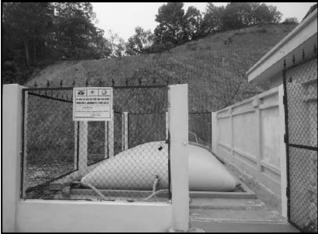
Mô hình thí điểm áp dụng công nghệ trữ nước bằng bồn chứa nhựa dẻo do công ty Labaronne CITAF, CH Pháp sản xuất tại Phố Ngọc, xã Trung Minh, TP Hòa Bình
