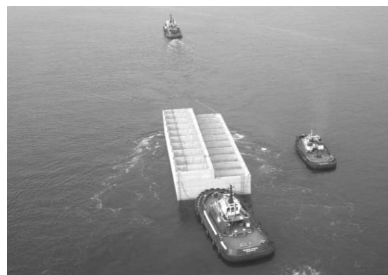
Hình 13: Di chuyển xà lan đến vị trí công trình
