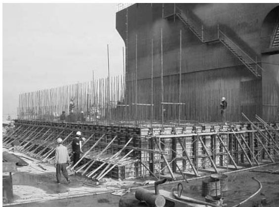
Hình 11: Hồ móng chế tạo xà lan
