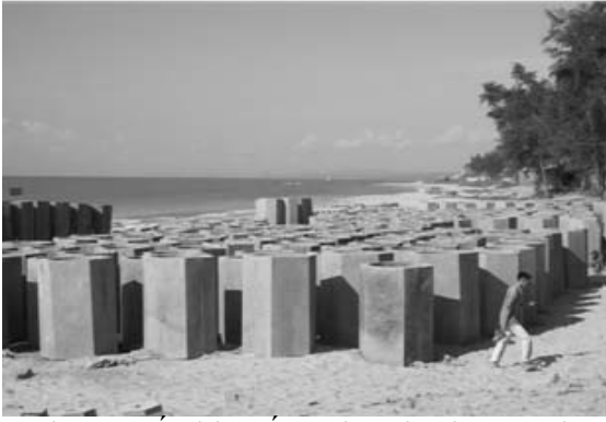
Hình 10: Cầu kiện ống phuy lục lăng sử dụng làm chân khay kè[1]
