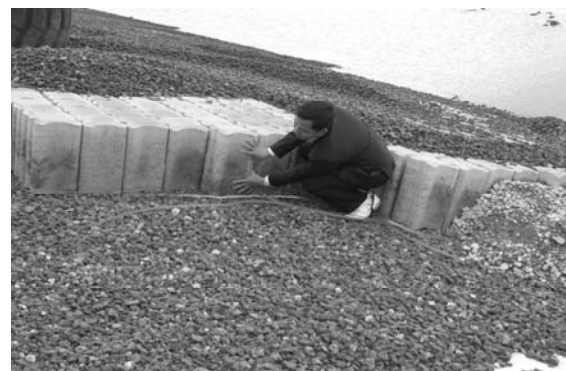
Hình 6: Thi công cấu kiện Hydroblock®
