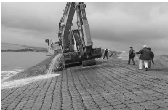
Hình 5: Mái kè biển ứng dụng cấu kiện Hydroblock® đã thi công hoàn thành
