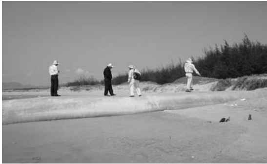
Hình 12: Kè ứng dụng stabiplate tại Lộc An- Vũng Tàu 2005
