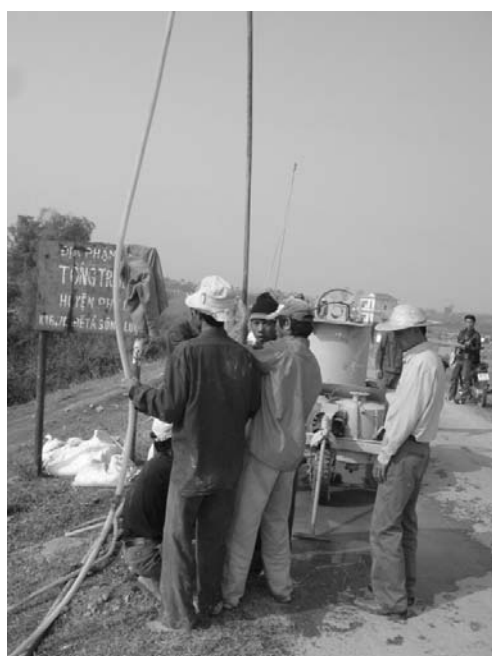
Hình 4: Xây dựng định mức khoan phụt vữa gia cố chất lượng thân đê
