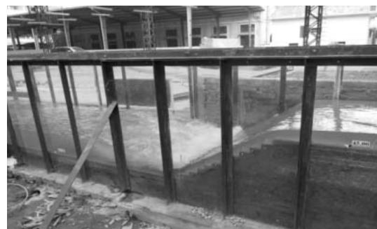
Hình 4: Nước nhảy ở hạ lưu đập trong mô hình.
