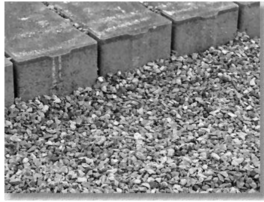
Hình 14: Kết cấu gạch tự chèn
