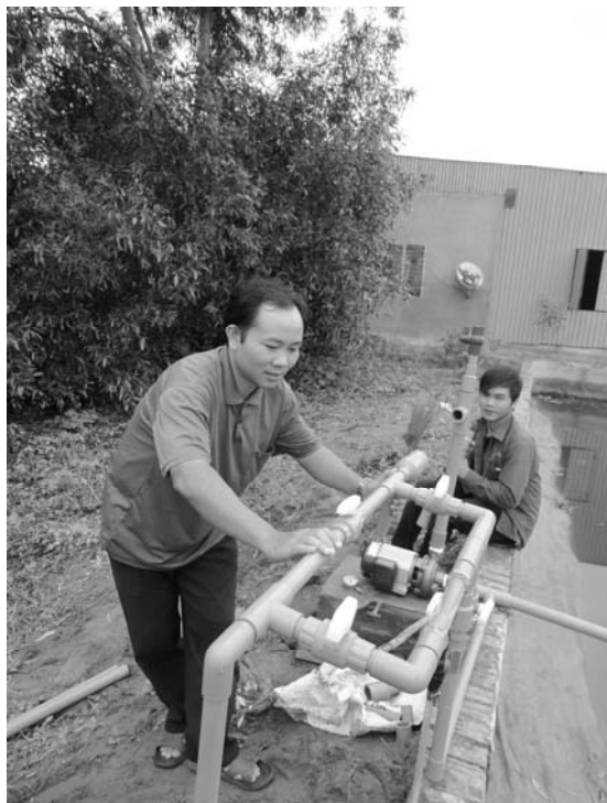
Hình 7: Thiết lập hệ thống tưới của mô hình tưới tiết kiệm nước cho cây nho lấy lá
