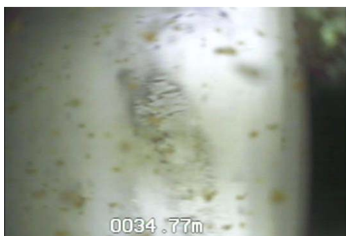
Hình 8. Tại độ sâu 34,77m phát hiện dấu vết bom khai thác va chạm với thành giếng [5]
