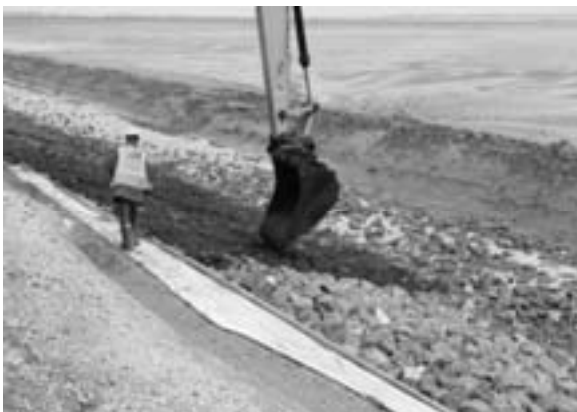
Hình 1. Ứng dụng vật liệu hỗn hợp asphalt chèn trong đá hộc thi công đê biển Hà Lan (năm 2013)
