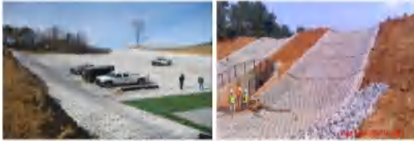
Hình 7: Tràn sự cố sử dụng ACB nằm ngoài và một phần thân đập [3]
