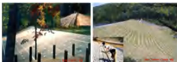
Hình 4: Ứng dụng cấu kiện ACB làm tràn sự cố trên đập đất [3]
