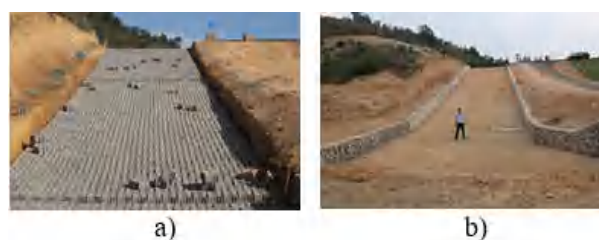
Hình 18: Hình ảnh công trình tràn sự cố Đắc Noh sử dụng cấu kiện ACB
