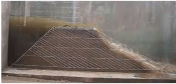
Hình 2: Ảnh hưởng của kết cấu gia cố đỉnh đập đến diễn biến xói [2]
