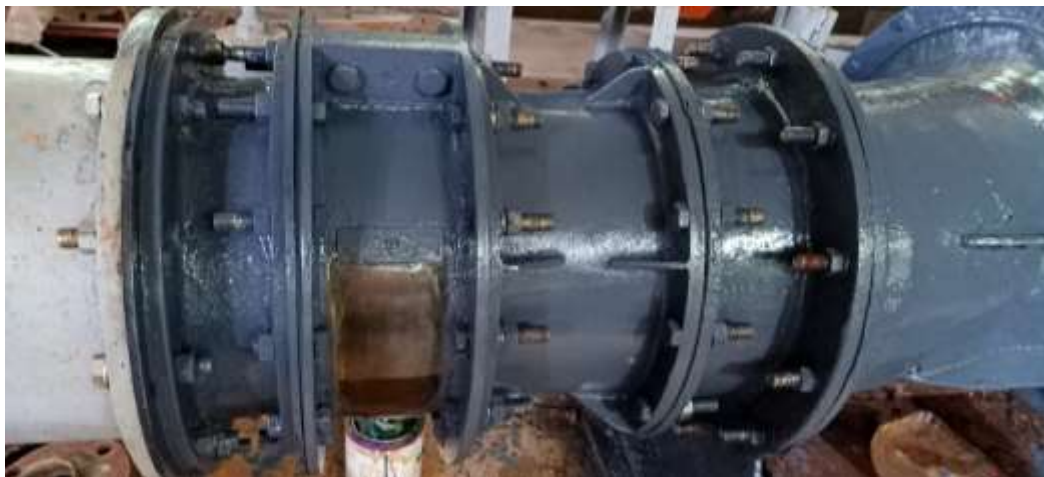
Cửa quan sát trên vỏ buồng cầu bánh công tác bơm mô hình
