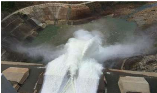
Ảnh 7: Đập tràn Sông Bung 4 xả lũ 2 khoang
