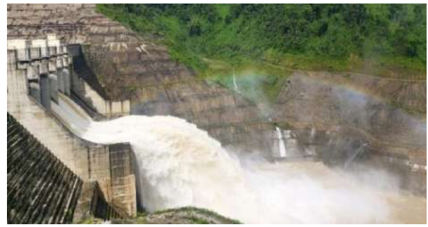
Ảnh 8: Đập tràn Sông Bung 4 xả lũ 6 khoang
