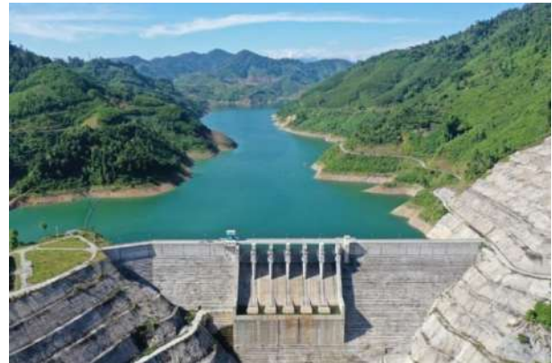
Ảnh 6: Đập tràn Sông Bung 4 xây dựng xong
