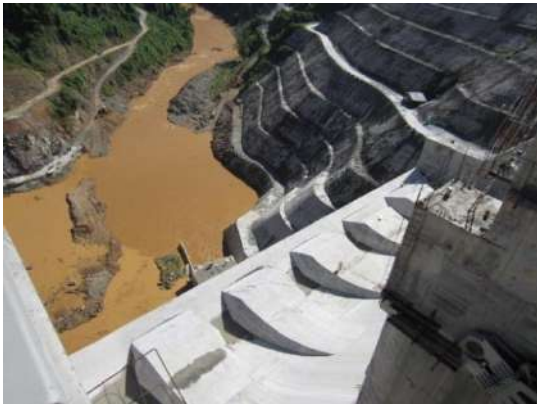
Ảnh 5: Đập tràn Sông Bung 4 đang xây dựng
