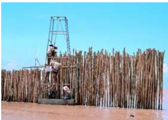
Hình 1: Thi công tường mềm giảm sóng
