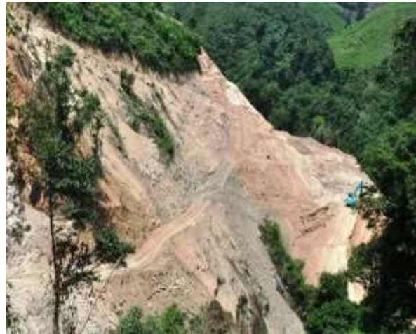
Hình 1: San ủi, chặt phá rừng để xây dựng thủy điện Đăk Re (Nguồn: Internet)
