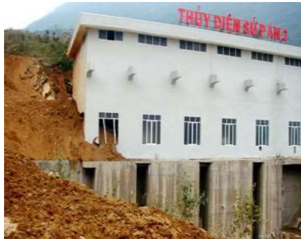
Hình 3: Thủy điện Sử Pán 2 bị vùi lấp
