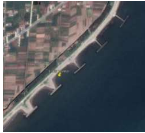
Hình 1.4: Công trình NCGS Hải Thịnh II
