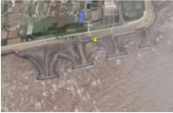
Hình 1.1: Công trình NCGS Ang Giao Phong
