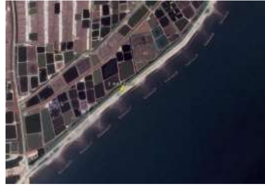
Hình 1.2: Công trình NCGS Kiên Chính
