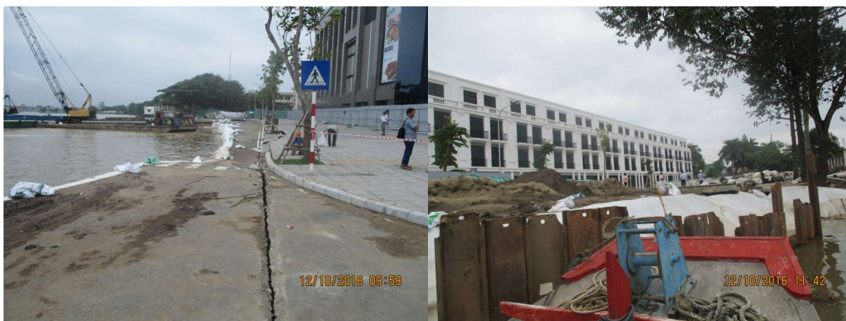
Hình 6: Hiện trạng bờ kè khu vực dự án VinCom Xuân Khánh
