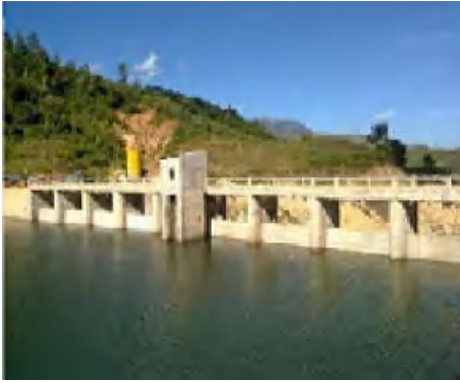
Hình 5: Cửa van tự lật - Công trình thủy điện Tà Lơi 2, Lào Cai
