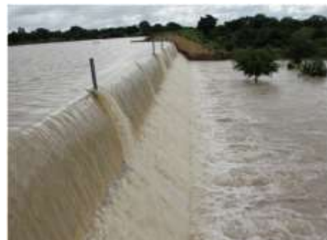
Hình 6: Khối bê tông tự lật ở đập Wedbila (Burkina Faso – châu Phi)
