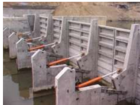
Hình 5: Cửa van tự lật kiểu bánh răng có thanh nối
