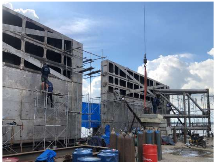
Hình 4. Kết cấu cửa van kiểu mới - cống kết hợp âu thuyền cống Xẻo Rô
