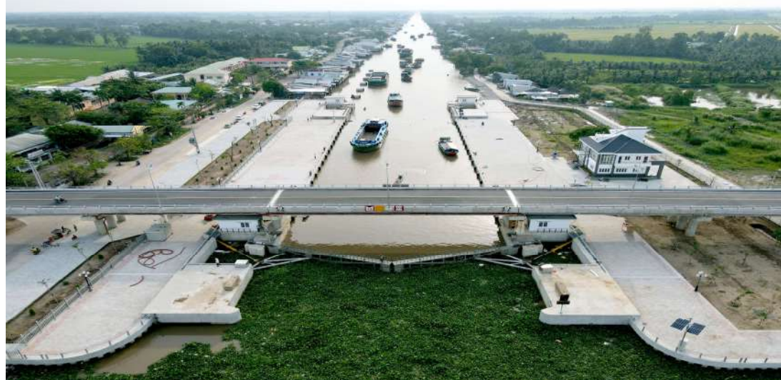
Hình 6. Công trình cống Xẻo Rô khi hoàn thành
