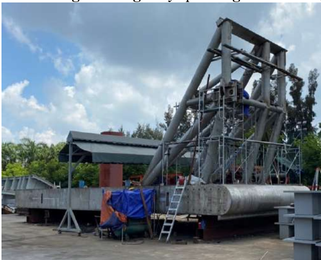
Hình 4. Kết cấu cửa van kiểu mới - cống kết hợp âu thuyền cống Xẻo Rô
