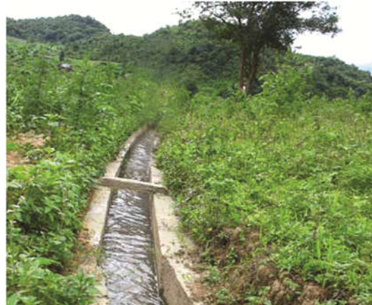
Hình 4. Kênh tiêu cắt dốc
