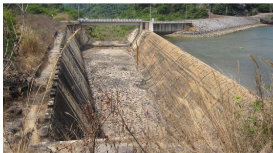
Hình 6. Đường tràn ngang và máng bên hồ Đa My, tỉnh Bình Thuận
