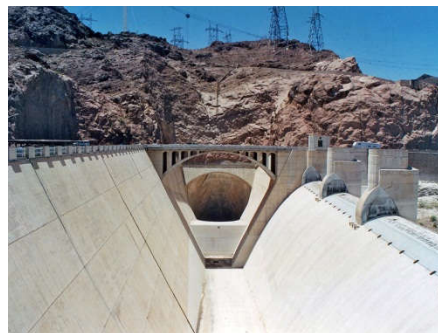
Hình 7. Đường tràn ngang và máng bên đập Hoover, Mỹ
