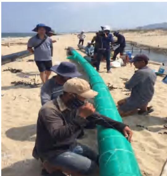
Hình 10: Một số hình ảnh thi công hệ thống lọc đặt ngầm ngoài biển
