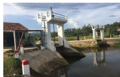
Hình 5: Cống điều tiết tự chảy lấy nước mặn vào ao nuôi tại Phú Yên
