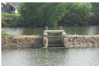
Hình 3: Lấy nước tự chảy qua cống tại Quảng Nam
