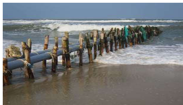
Hình 6: Trạm bơm đặt trong bờ, ống hút đi nổi trên mặt đất
