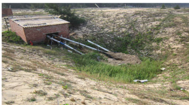
Hình 1. Mô hình trạm bơm tại xã Đức Minh, huyện Mộ Đức, tỉnh Quảng Ngãi
