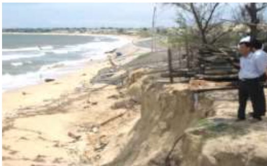
Hình 5: Sạt lở bờ biển Bình Thuận do triều cường cùng sóng lớn, nước dâng do bão (hình bên trái), và giải pháp bảo vệ bằng bao cát (hình bên phải)
