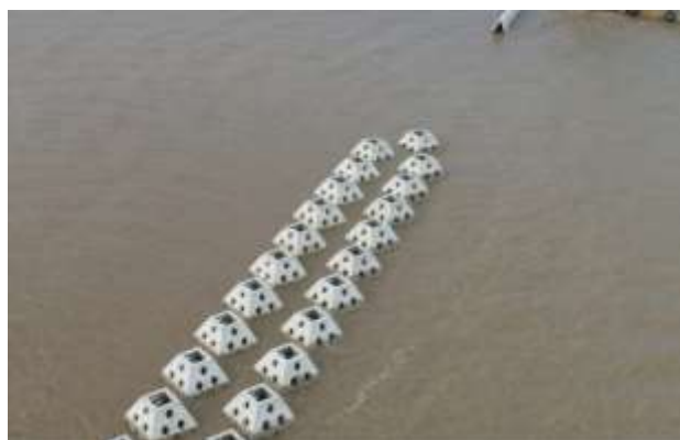
Hình 18: Cấu kiện nối ghép Max 400 có khả năng tháo lắp, di chuyển ứng dụng cho công trình giảm sóng xa bờ
