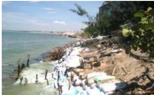
Hình 5: Sạt lở bờ biển Bình Thuận do triều cường cùng sóng lớn, nước dâng do bão (hình bên trái), và giải pháp bảo vệ bằng bao cát (hình bên phải)
