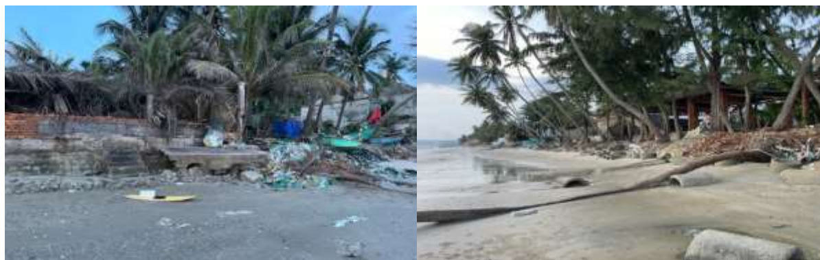
Hình 10: Sạt lở bờ biển Hàm Tiến, ảnh chụp 2023 [7]
