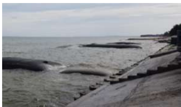
d) Kè mở hàn (I) Geotub KDL Coco
