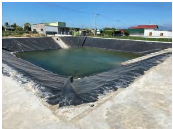
Hình 7: Mặt bằng và cắt dọc bể chứa 500 m 3 ; ảnh bể đã hoàn thiện
