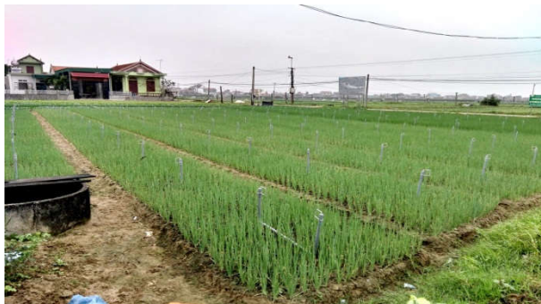
Hình 3: Hình ảnh khu tưới đã lắp đặt xong
