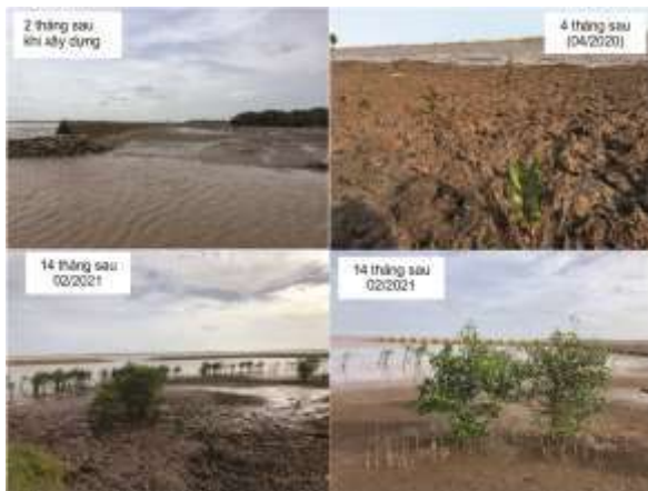
Hình 10: Hiệu quả giảm sóng của công trình bảo vệ bờ biển Côn Cống (tháng 12/2019)
