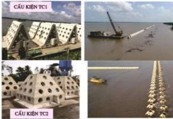
Hình 6: Quá trình vận chuyển và thi công đê giảm sóng kết cấu rỗng TC1, TC2 tại bờ biển Cồn Cống-Tiền Giang
