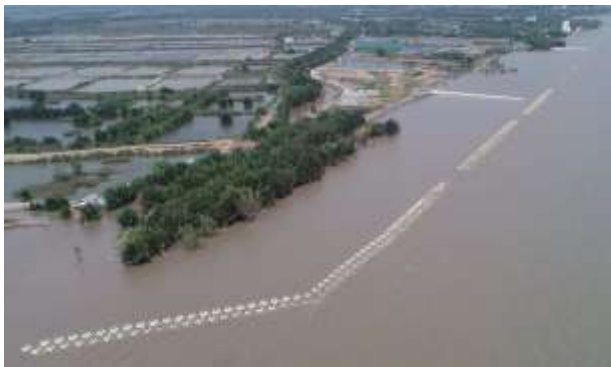
Hình 7: Tuyến công trình bảo vệ bờ biển Cồn Cống hoàn thiện tháng 12/2019 (trái) và bãi bồi tháng 05/2020 (phải)
