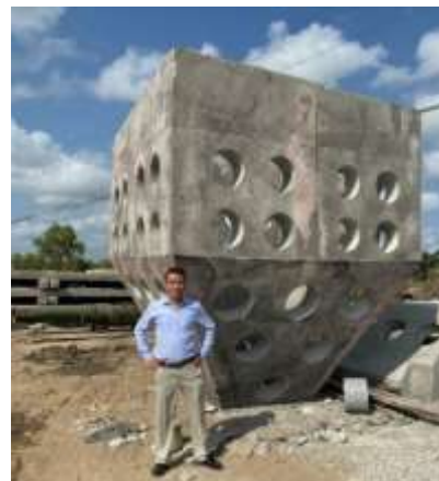
Hình 9: Công tác đúc cấu kiện TC2 chuẩn bị thi công (5/2021)
