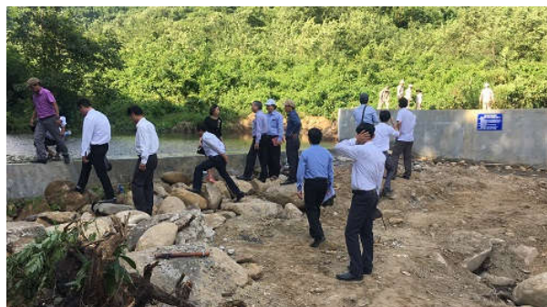
Hình 5. Suối Hội Yên sau khi xây dựng đập dâng để tạo đầu nước cho bơm va
