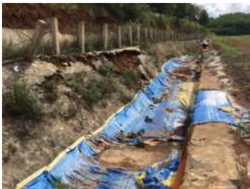
Hình 3: Hư hỏng rãnh thu nước ngoại vi
