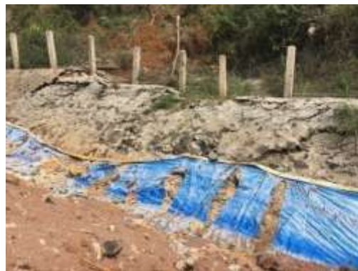
Hình 3: Hư hỏng rãnh thu nước ngoại vi
