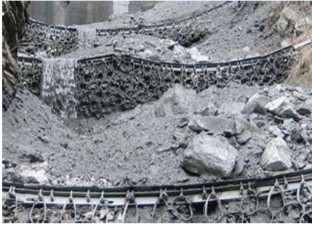
Hình 3: Hệ thống lưới thép nhiều lớp đang hoạt động [4]
