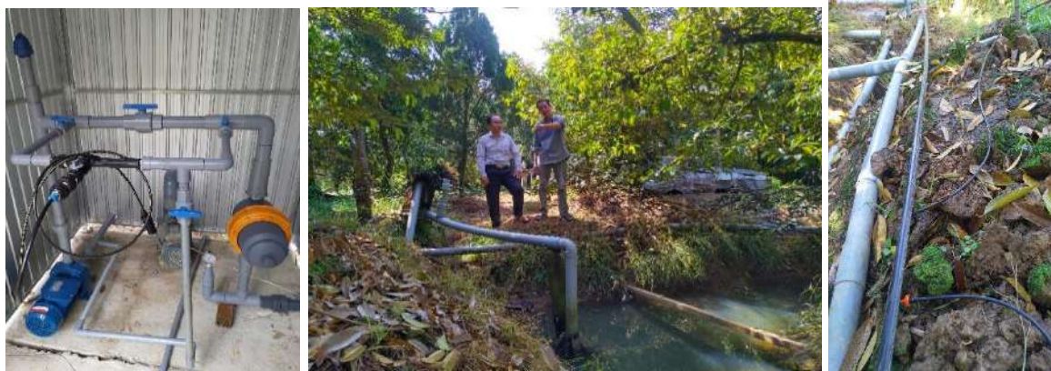
Hình 2: Thi công lắp đặt hệ thống tưới tại mô hình sầu riêng Tiền Giang
