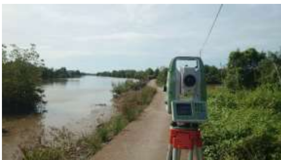
Khảo sát địa hình bằng máy toàn đạc điện tử
