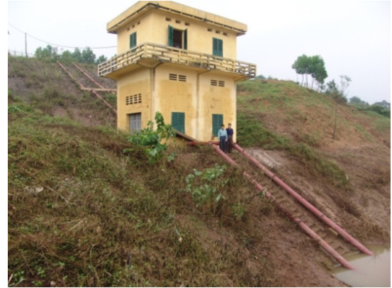
Hình 13. Trạm bơm cột hút sâu trên sông Đuống (Giang Biên, Long Biên)
