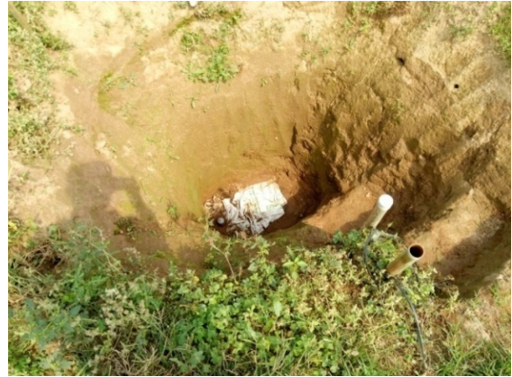
Hình 7. Hạ thấp cao trình máy bơm giếng khoan ở xã Tàm Xá, Đông Anh
