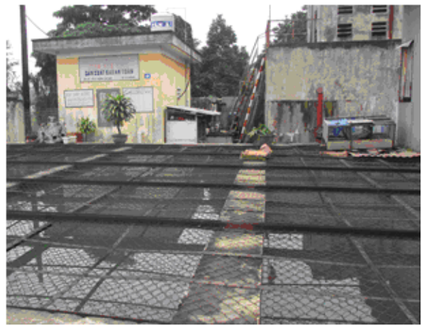
Hình 9. Trạm khai thác nước ngầm phường Lĩnh Nam (bãi sông Hồng)
