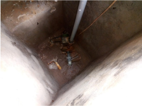
Hình 6. Hạ thấp cao trình máy bơm giếng khoan ở xã Văn Đức, Gia Lâm
