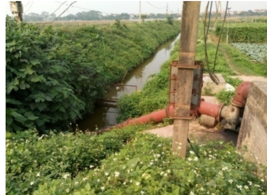
Hình 5. Trạm bơm đã chiến xã Văn Đức
