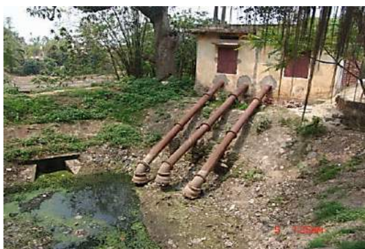
Hình 5: Nối dài ống hút máy bơm
