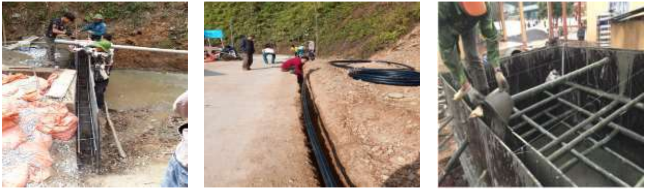
Hình 13: Thi công đập ngầm, đường ống, bể chứa nước
