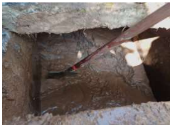
Hình 2: Đất sạt lở vùi lấp đầu mối và phù sa lắng đáy bể trữ nước của hệ thống cấp nước sinh hoạt thôn Lịch Cang (Năm Lịch, Mường Ảng, 2019)
