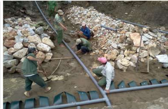
Hình 5: Sơ đồ bố trí hệ thống thu gom nước mái đồi - Công trình hào thu nước mái đồi ở bản Chiềng Chấn 3, xã Chấn nửa, tỉnh Lai Châu.
