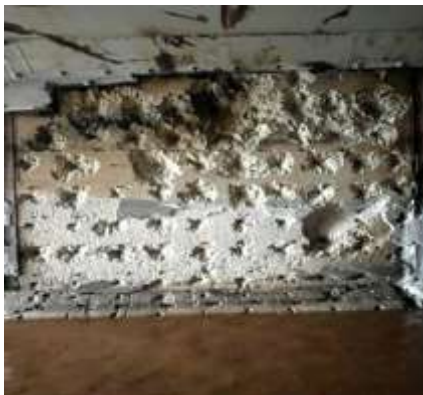
Ảnh 3: Bê tông bị kéo lột tại các vị trí khoan neo
