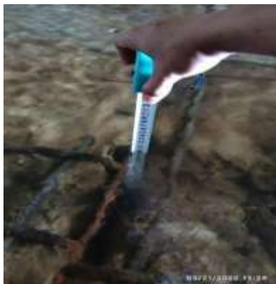
Ảnh 4: Bê tông bị kéo lột tại các vị trí khoan neo ở đáy cống
