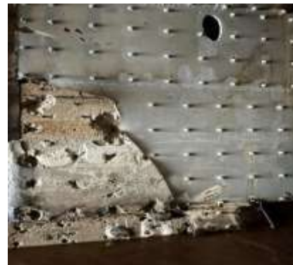
Ảnh 3: Bê tông bị kéo lột tại các vị trí khoan neo
