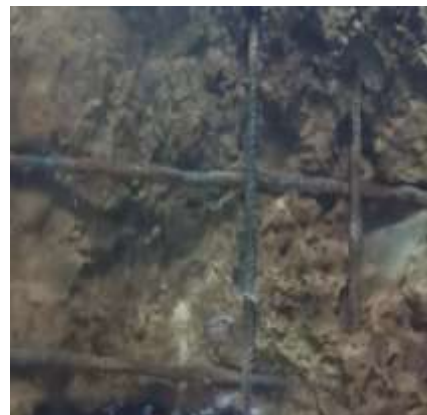
Ảnh 4: Bê tông bị kéo lột tại các vị trí khoan neo ở đáy cống
