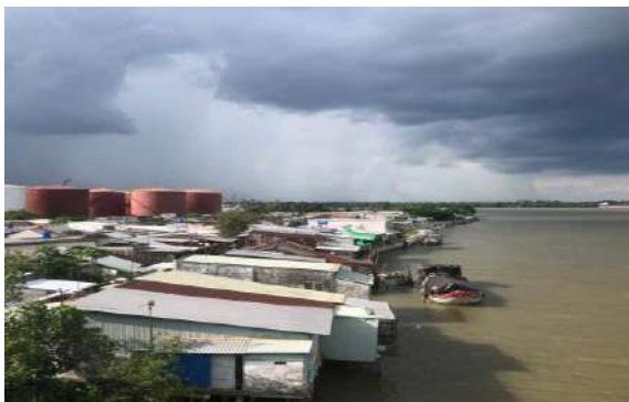
Hình 4: Đặc tính sinh hoạt, xây dựng công trình dân sinh sát bờ
