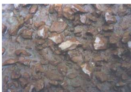
Hình 3: Hiện tượng sóng biển tác động vào bề mặt bê tông và ăn mòn, rửa trôi
