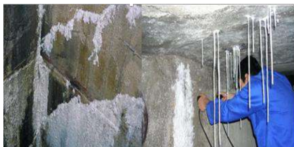
Hình 1: Hiện tượng thẩm thấu vôi ( \text{Ca(OH)}_2 ) ( R_{bt} giảm từ 10-40% so với những vị trí bê tông đặc chắc)
