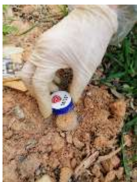
Hình 3: Kiểm tra và bổ sung bả vào đập Đồng Mô, Vĩnh Phúc
