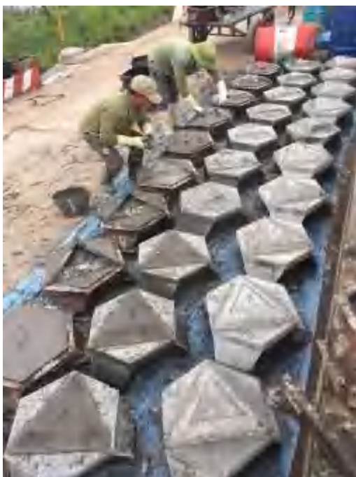
Hình 1: Chế tạo cấu kiện bê tông
