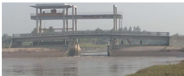
Hình 6: Hiện trạng công hở ĐBSCL (chưa mở thêm khoang công)
