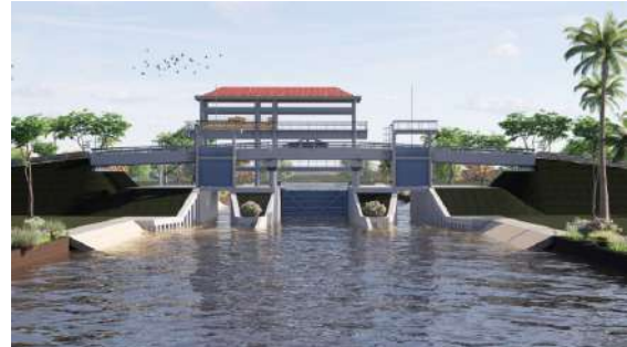
Hình 16. Cống tương ứng đã mở thêm 2 khoang ở 2 bên mang cống đã có
