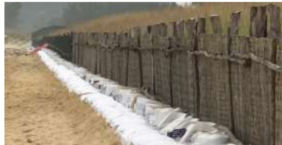
Hình 7: Bao cát vải địa kỹ thuật được bố trí tại mô hình
