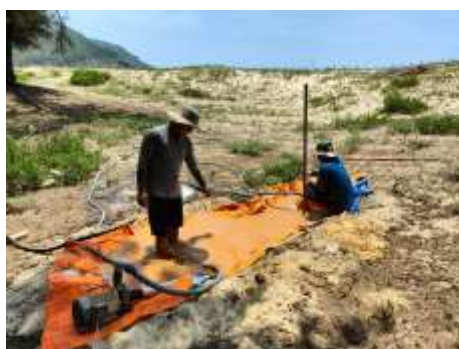
Hình 10: Đào giếng khoan, bố trí máy bơm và thiết bị tưới tại mô hình
