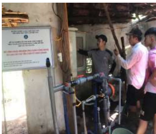
Hình 9: Lắp đặt hệ thống tưới kết hợp bón phân tại mô hình hồ tiêu
