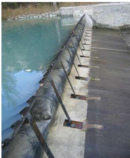
Hình 3: Cửa van CSBM sáng chế bởi công ty Obermeyer được sử dụng ở đập tràn của nhà máy thủy điện Achwa II (Uganda)
