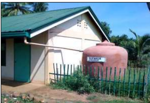
Hình 2: Hệ thống thu gom và xử lý nước mưa có bộ lọc Biosand ở Caribe [2]
