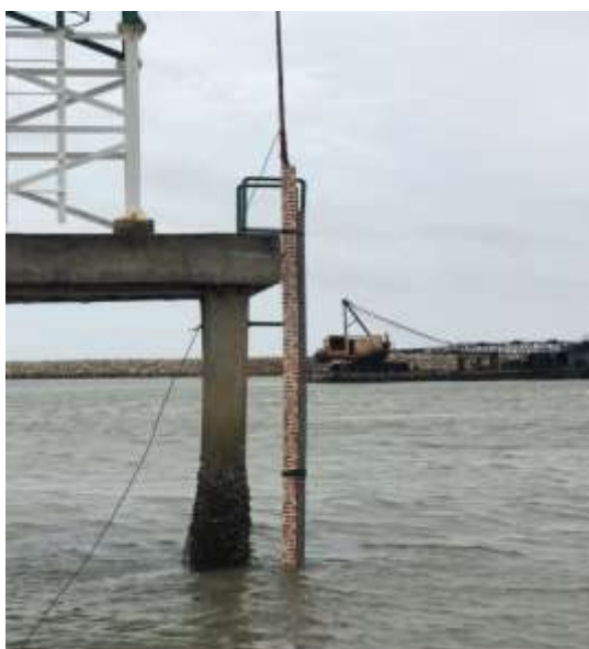
Hình 7: Trạm quan trắc mực nước liên kết mốc DH-05
