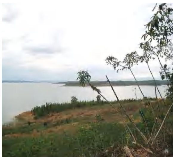
Hình 1: Khu vực yên ngựa dự kiến đào đường hầm chuyển nước mùa lũ hồ TĐ Plei Krông sang H. Đăk Sa Men
